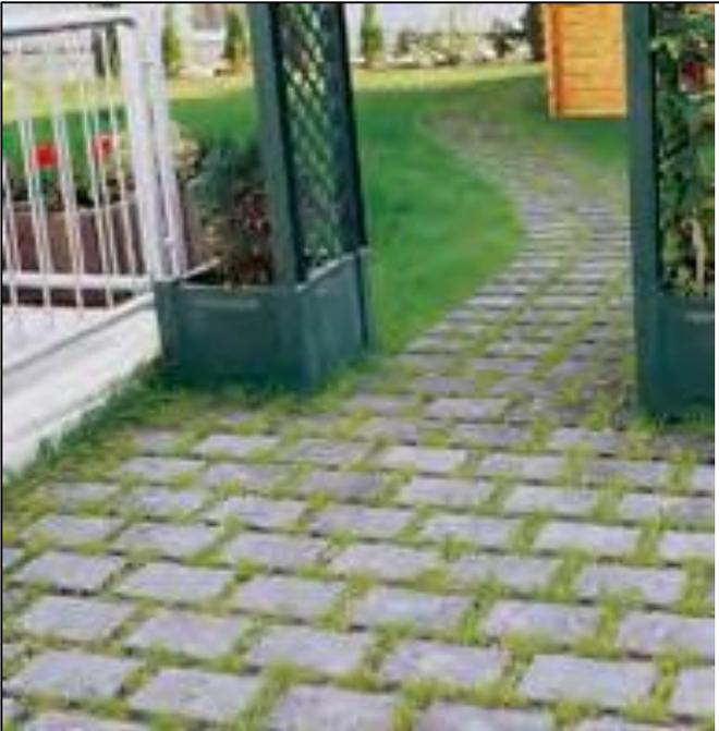
Rasenfugenpflaster besteht aus Betonsteinen mit angeformten Abstandhaltern, die gleichmäßig breit begrünte Fugen gewährleisten.
