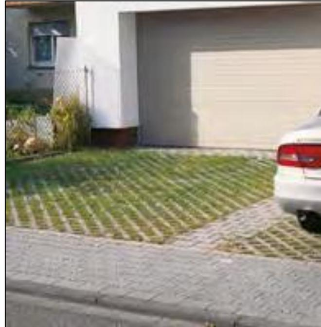
Rasengittersteine bestehen aus Beton und haben wabenförmige Öffnungen, die mit sandigem Mutterboden gefüllt und mit Gras bewachsen sind.
